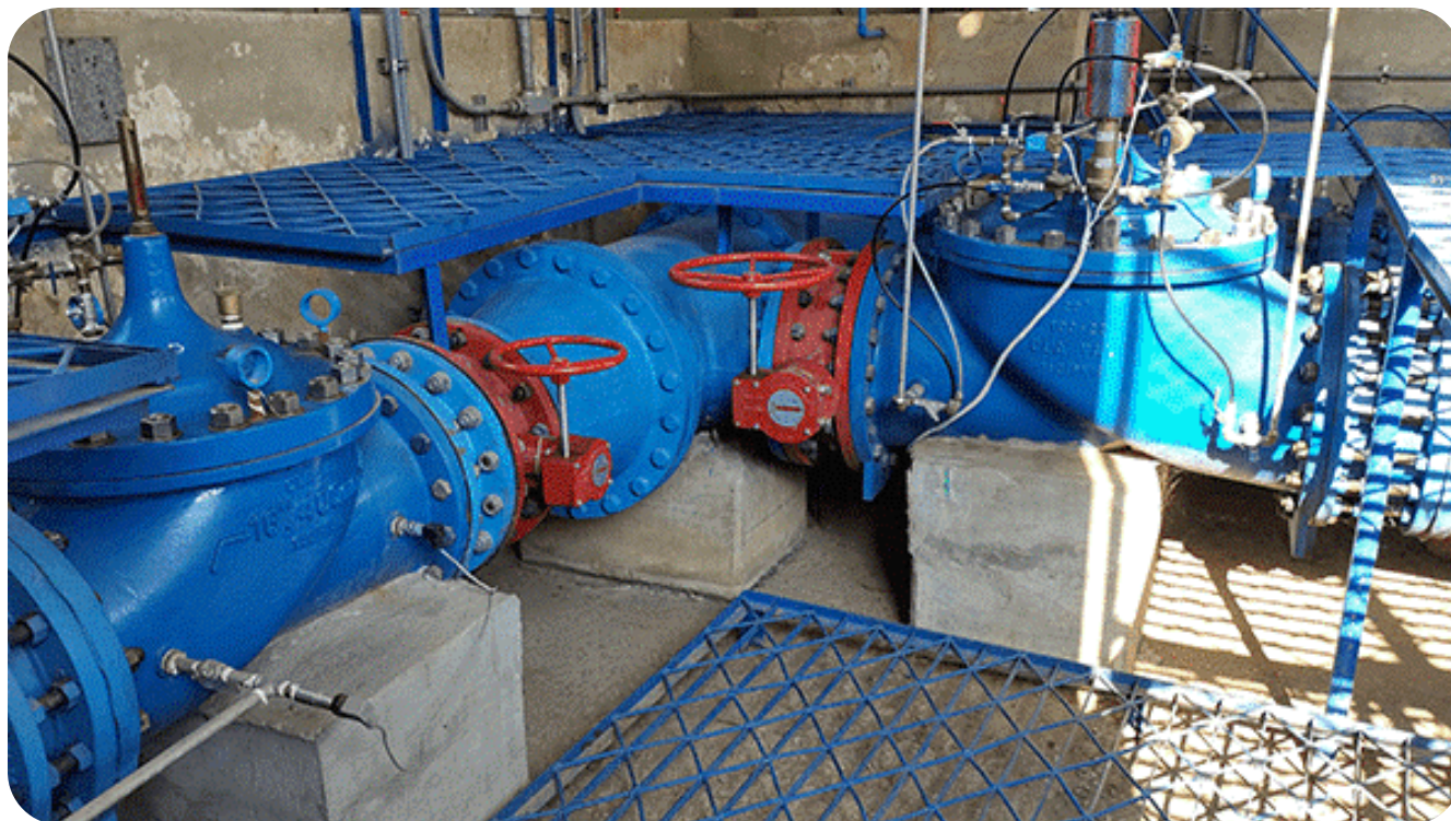
Figuras 4. Válvulas Reductoras de Presión suministradas e instaladas.
