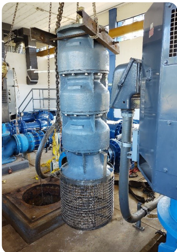
Figuras 2 y 3. Repotenciación de equipo de bombeo y conexión hidráulica de redes.
